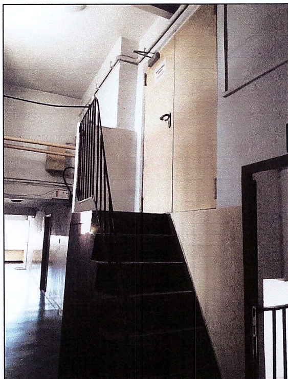
Dojście do maszynowni
