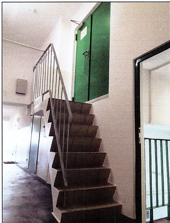
Dojście do maszynowni
